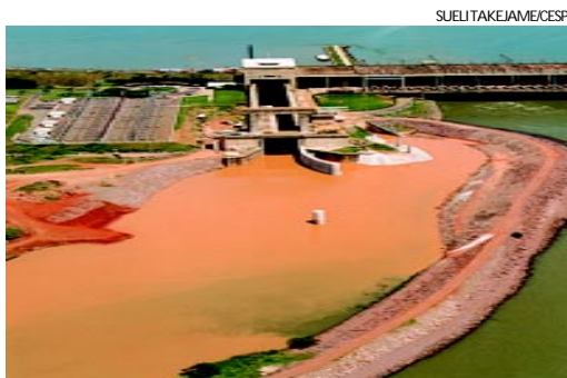
Com a eclusa de Jupiá, foram concluídas as obras da Hidrovia Tietê-Paraná
